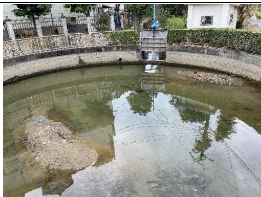
水位觀測池及水閘門現況 拍攝日期：113.1.25
