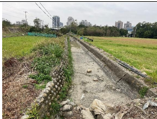
東興圳渠道現況 拍攝日期：113.1.25
