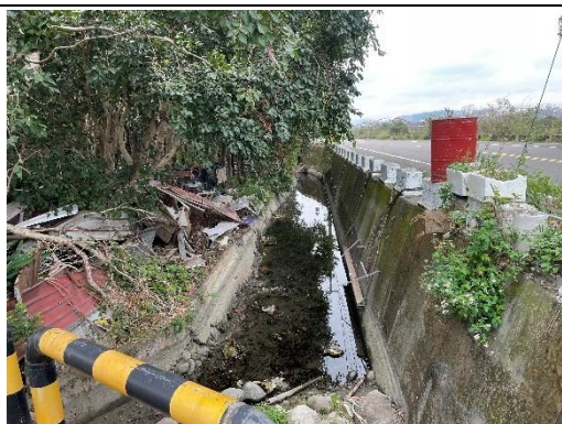
東興圳渠道現況 拍攝日期：113.1.25
