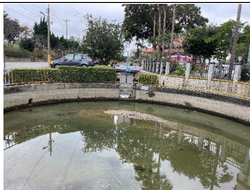
水位觀測池及水閘門現況 拍攝日期：113.1.25
