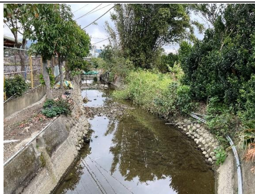
東興圳渠道現況 拍攝日期：113.1.25
