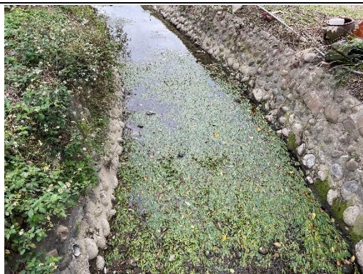
東興圳渠道現況 拍攝日期：113.1.25
