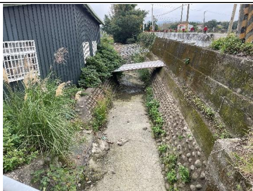
東興圳渠道現況 拍攝日期：113.1.25
