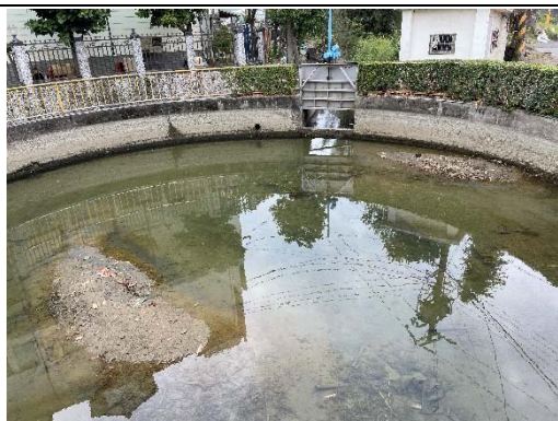
水位觀測池及水閘門現況 拍攝日期：113.1.25
