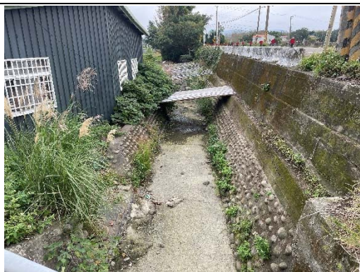
東興圳渠道現況 拍攝日期：113.1.25
