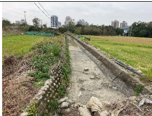
東興圳渠道現況 拍攝日期：113.1.25
