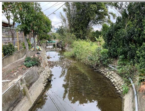
東興圳渠道現況 拍攝日期：113.1.25
