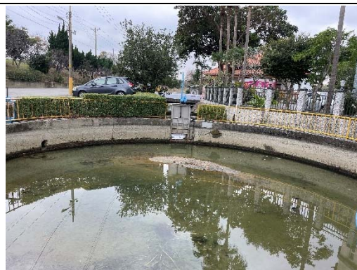
水位觀測池及水閘門現況 拍攝日期：113.1.25
