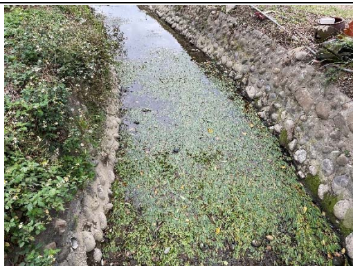
東興圳渠道現況 拍攝日期：113.1.25
