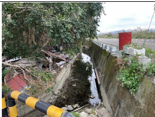
東興圳渠道現況 拍攝日期：113.1.25
