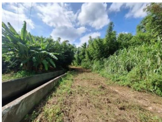
圖 32、施工便道導水路南岸
