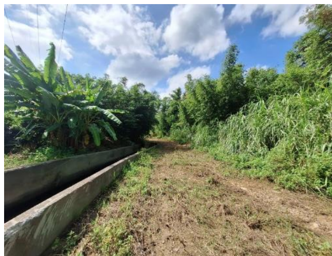
導水路南岸整地情形
