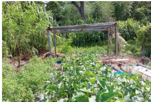
圖 31、施工便道現勘情形
