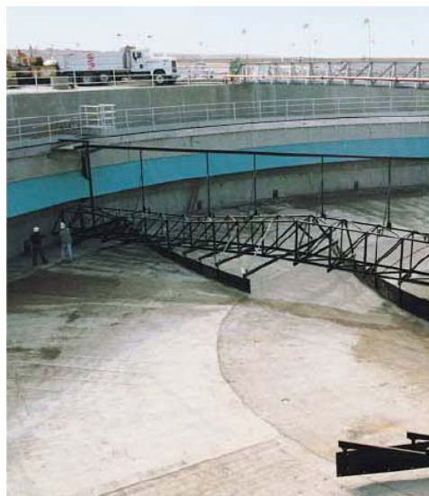
圖 3-139 百葉式彎刮板
