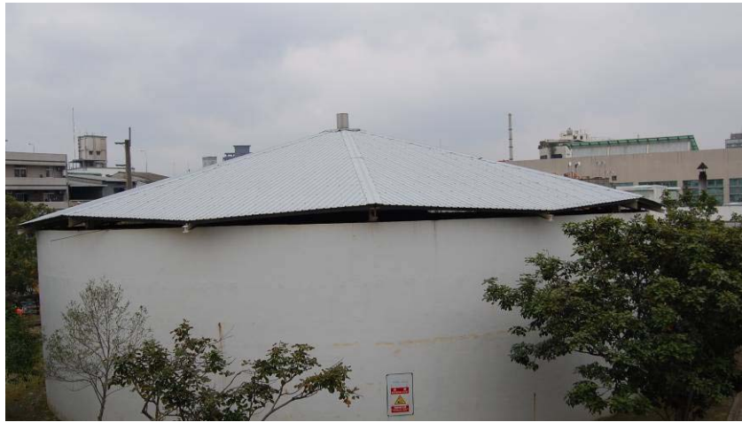
圖 7-19 消化瓦斯貯槽（迪化污水處理廠例）
