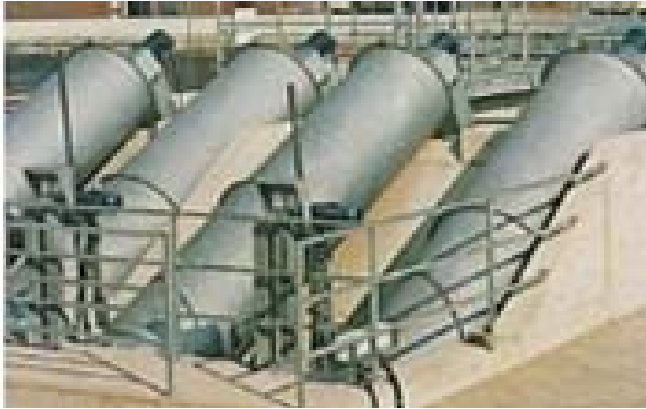
a. 閉合型螺旋抽水機安裝圖
