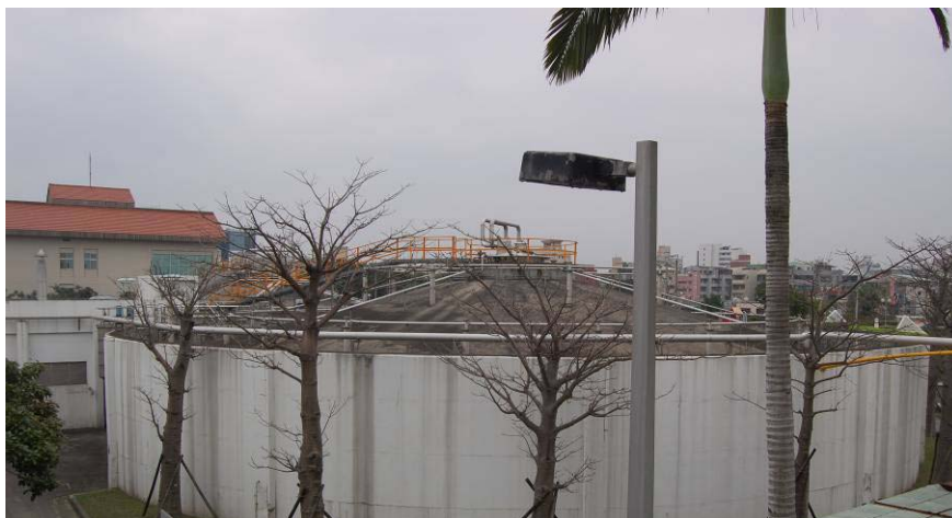
圖 7-18 厭氧消化槽（迪化污水處理廠例）
