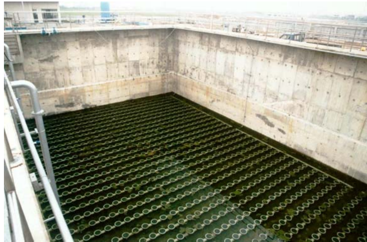
圖 4-22 散氣裝置及空氣管線
