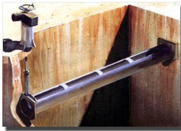
圖 3-122 長方形池刮渣管安裝示意圖
