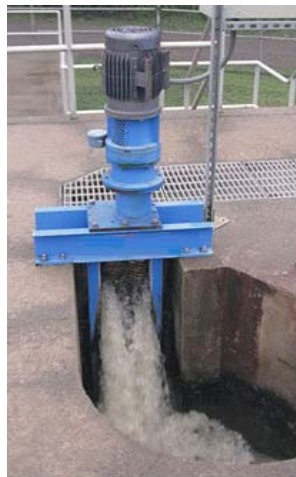
a. 渠道型切碎機示意圖及實物照片
