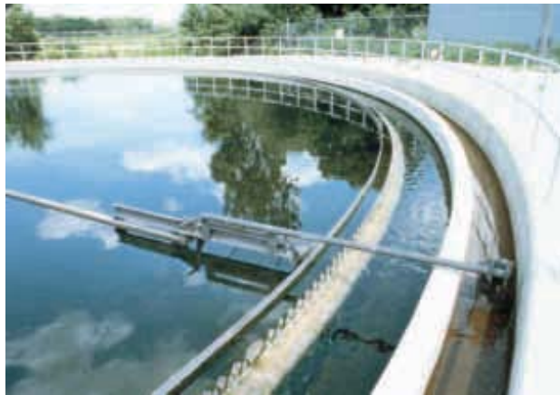
圖 3-119 周邊進水式沉澱池照片
