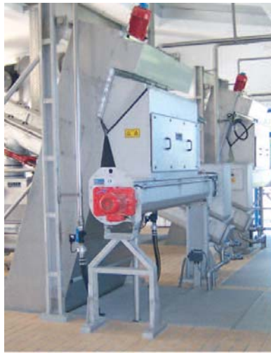
b. 階梯式細攔污柵裝設照片
