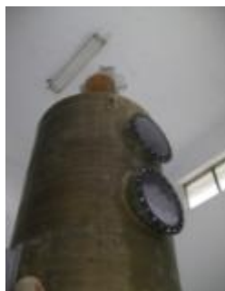
(a) 氯氣中和設備
