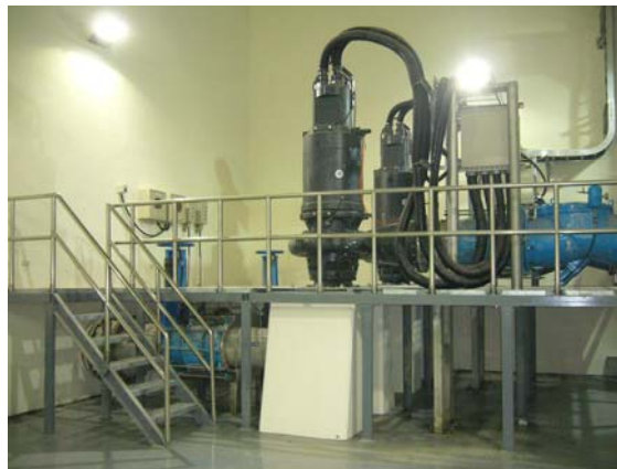
圖 3-83 進流抽水站乾井使用沉水式抽水機的相片（新竹客雅水資源回收中心例）
