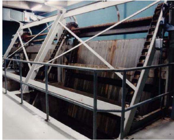
b. 實際安裝照片
