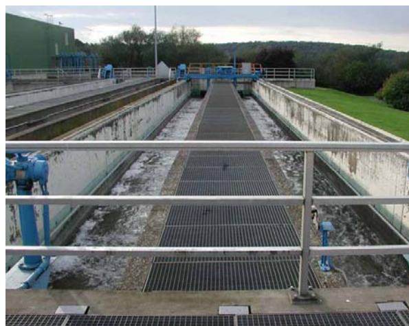
a. 曝氣沉砂池照片
