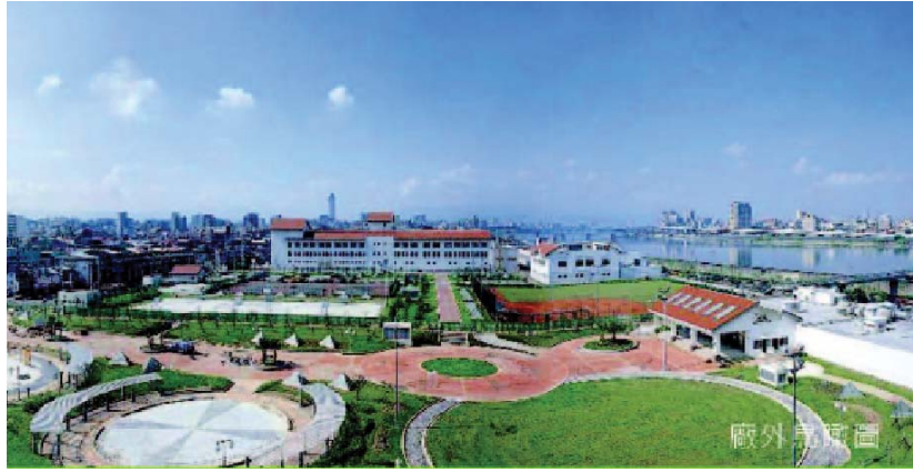
圖 2-9 迪化污水處理廠廠區上層加蓋頂層作為球場及休閒設施照片
