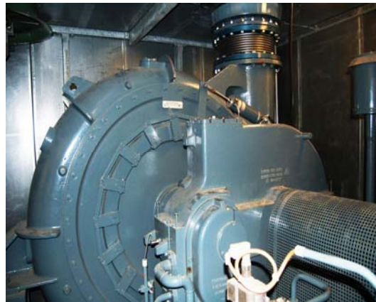
圖 4-26 單段離心式鼓風機(馬達+減速機驅動)
