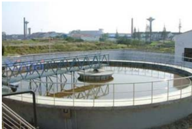
圖 7-8 浮除式濃縮槽
