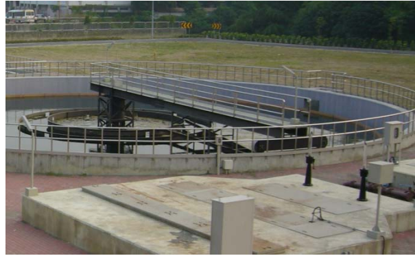
圖 3-143 周邊驅動式驅動機照片 (斗六市水資源回收中心例)
