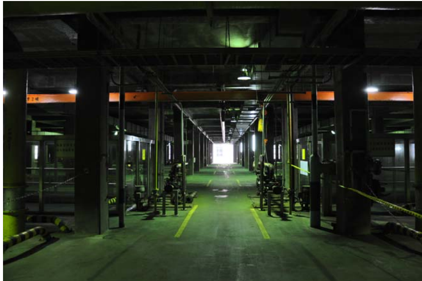
圖 2-12 內湖污水處理廠池槽頂版操作區照片
