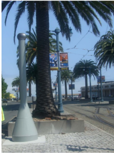
圖 1-38 舊金山 Embarcadero 地區頂端裝有旋轉風罩的通氣設施
