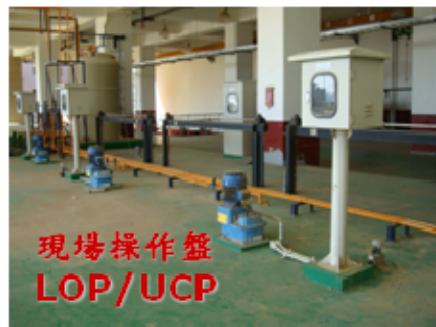
圖 9-26 儀控系統組合配置實景圖之二
