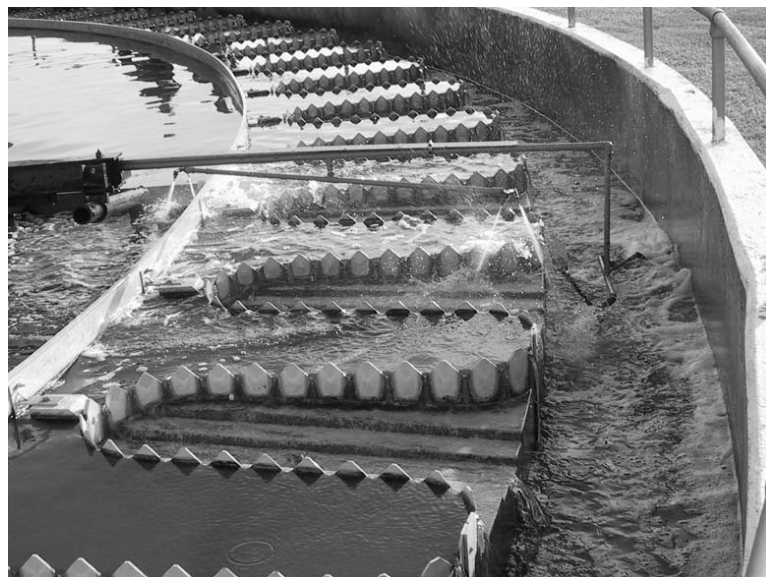
圖 3-126 噴水系統去除圓形池蛇狀溢流堰上的藻類
