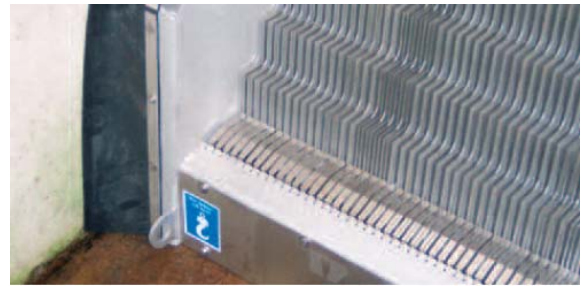
c. 裝設在渠道內之階梯式柵板
