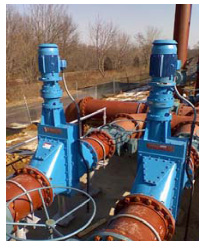
b. 管線型切碎機示意圖及實物照片
