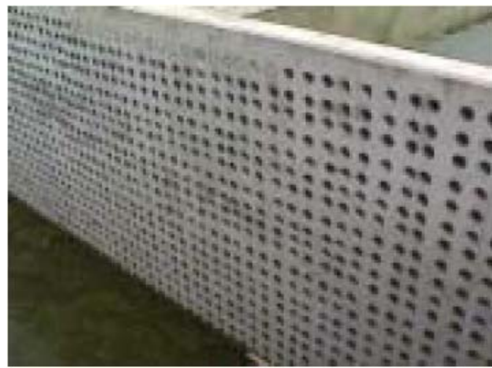
b. 混凝土整流壁照片
