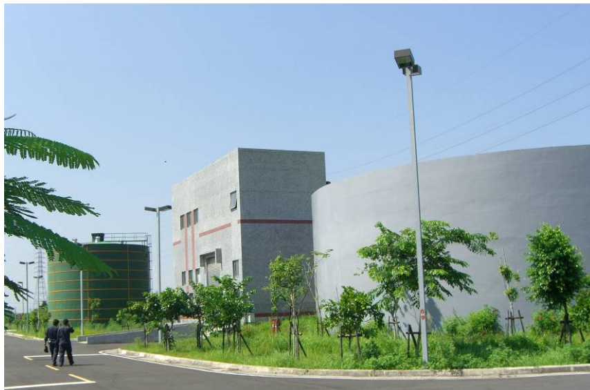
圖 7-15 厭氧消化槽 (六塊厝污水處理廠例)
